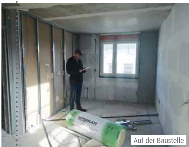
Der Ausbau ist in vollem Gange
