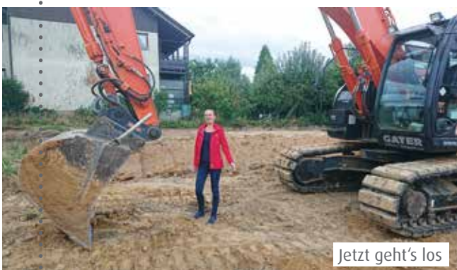
Vor dem Baustart
