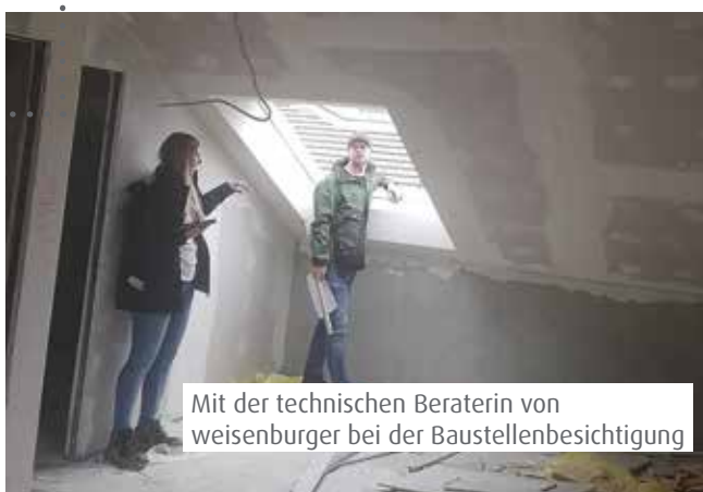
Auf der Baustelle
