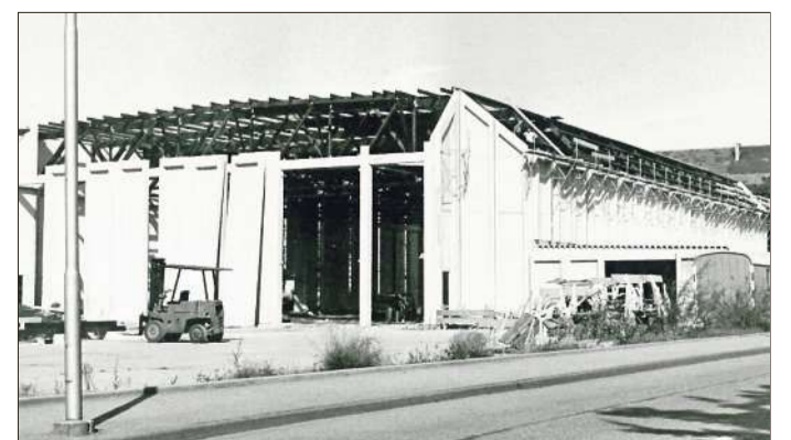
Baustelle: Die Eislaufhalle erhält ihr markantes Äußeres. Im November 1981 wird sie eröffnet. Fotos: av
